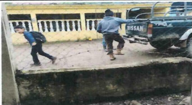
Foto1: Construcción de 28 mts. Lineales por 3.70 mts. Altura que equivale a 103.60 mts.2 de muro perimetral en la parte frontal de la escuela
